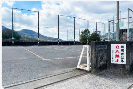
正門から見た駐車場
